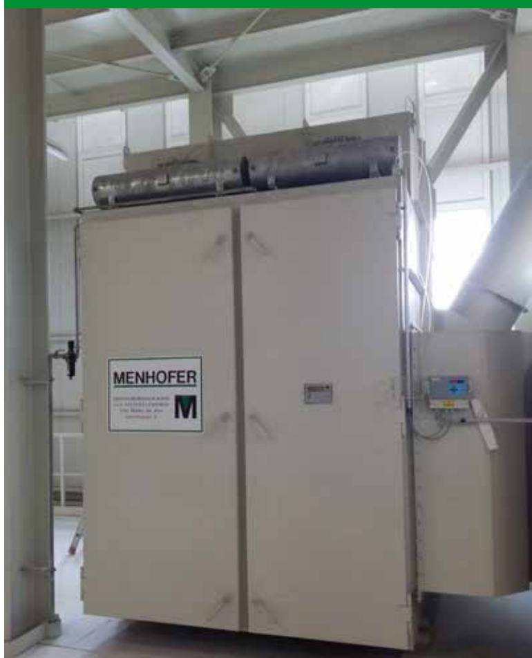
MENHOFFER Oval-Schlauchfilter mit seitlich montierter Vorabscheidekammer. MENHOFFER oval-bag dust collector with side-mounted pre-separator.
