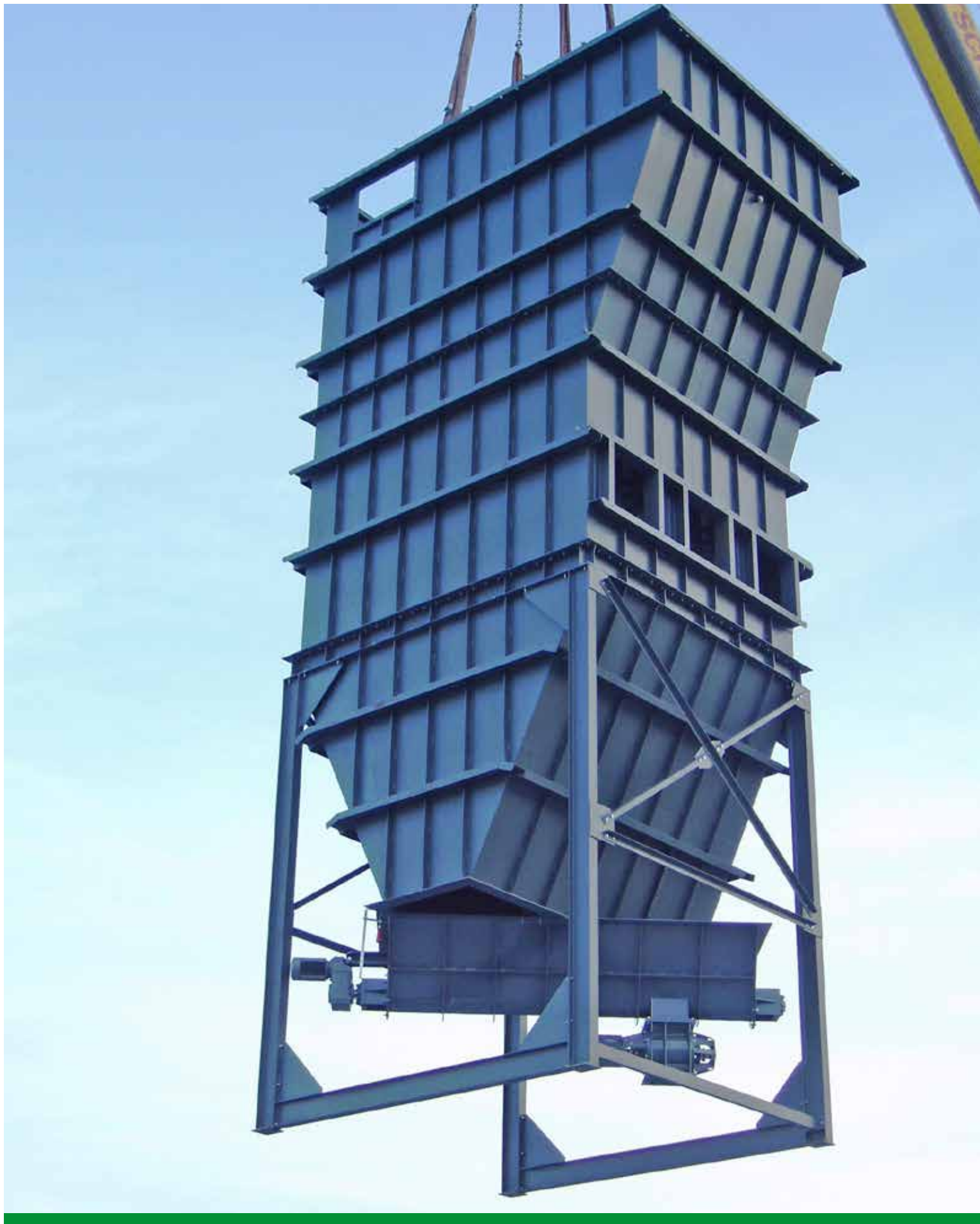
MENHOFER Rund-Schlauchfilter gemäß ATEX-Richtlinie während der Montage. MENHOFER round-bag dust collector according to the ATEX-guideline during the mounting.
