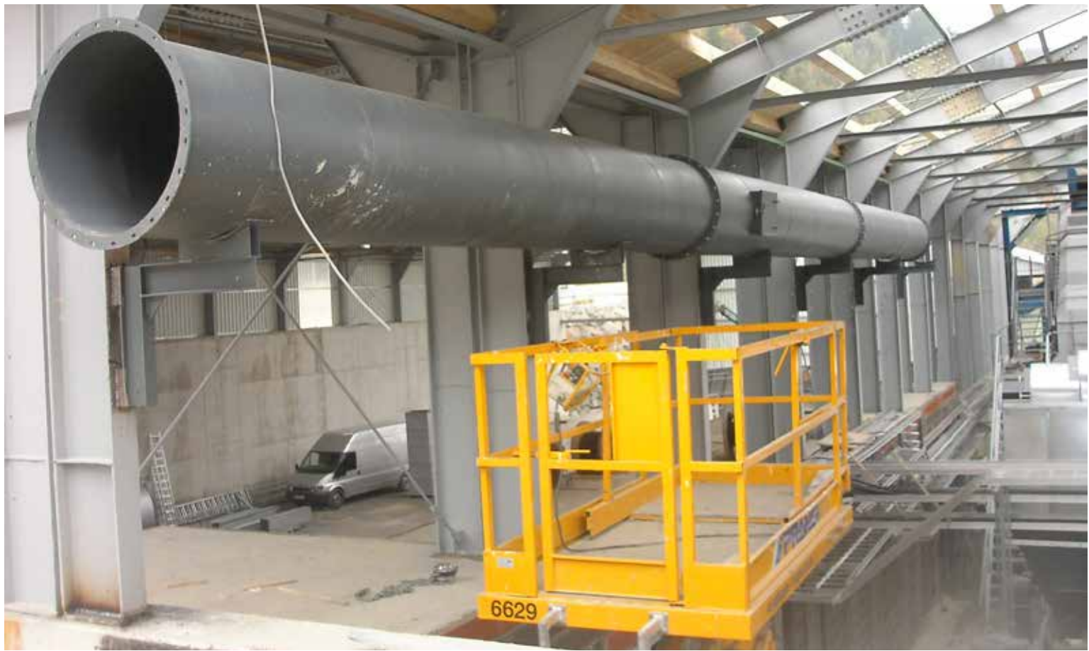
Entstaubungsrohrleitungen während der Montage. Dedusting pipes during the mounting.
