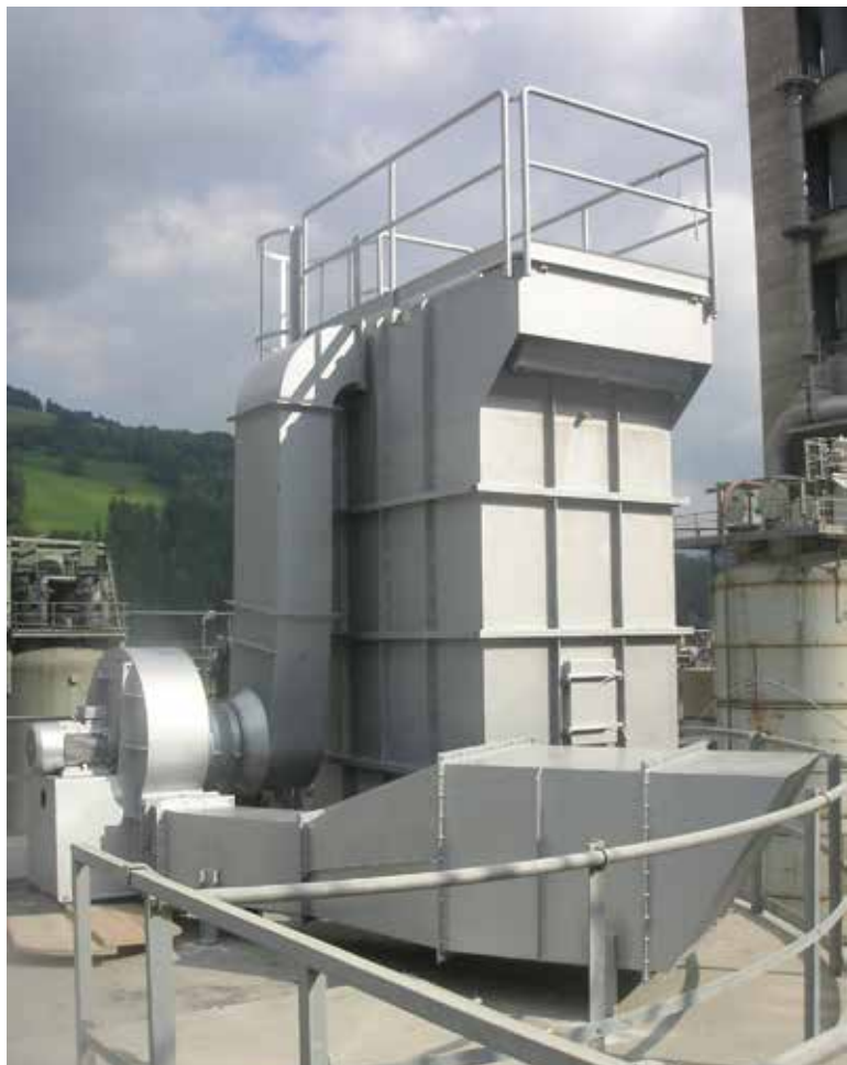
MENHOFER Oval-Schlauchfilter. Ausführung als Siloaufsatzfilter. MENHOFER oval-bag dust collector. Designed as silo filter.
