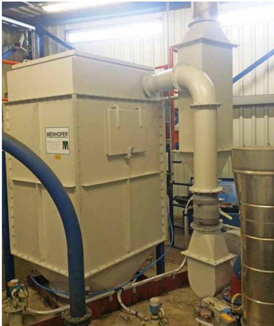
MENHOFER Oval-Schlauchfilter. Ausführung als Siloaufsatzfilter. MENHOFER oval-bag dust collector. Designed as silo filter.
