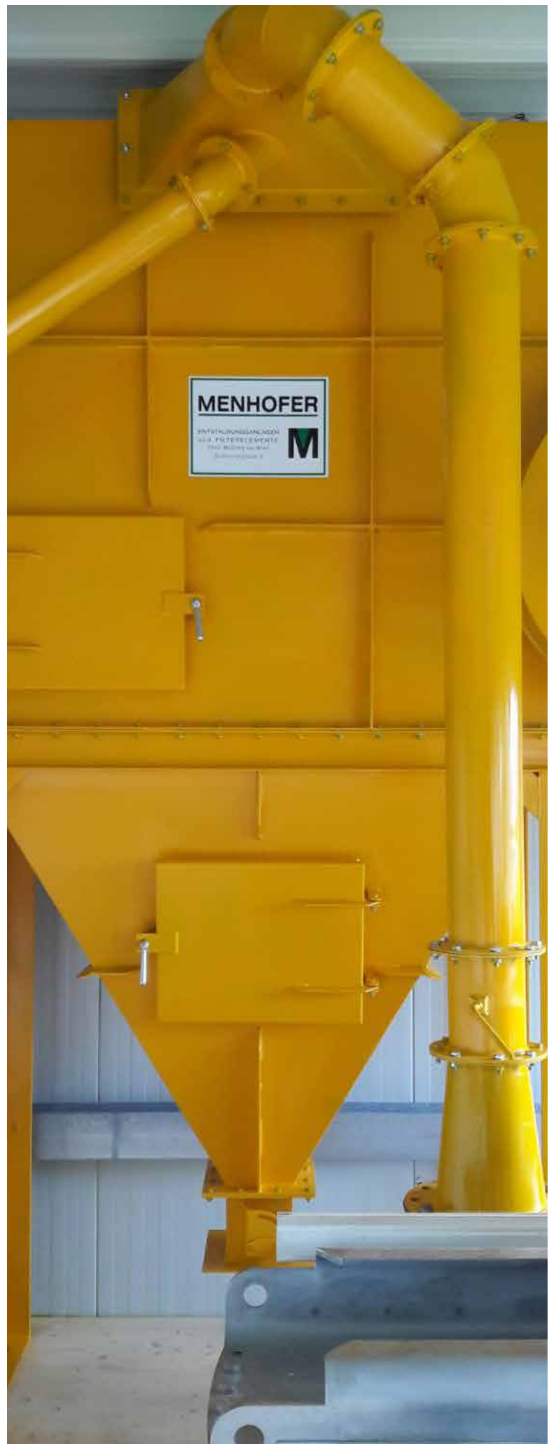
MENHOFER Oval-Schlauchfilter mit Unterst tzungsger st und Rohrleitungen.
